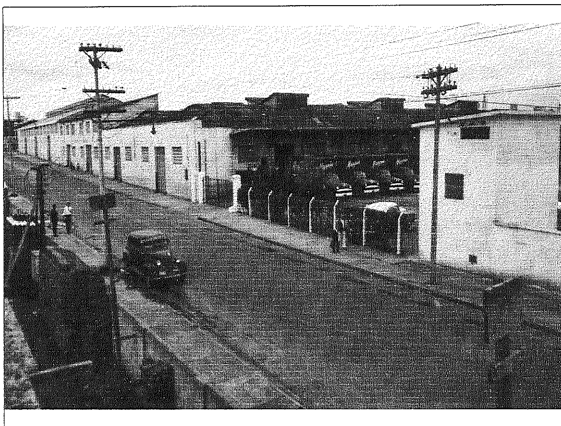
Quadro 3.11 – Vista do depósito do Itaim com a lateral voltada à Rua João Cachoeira
